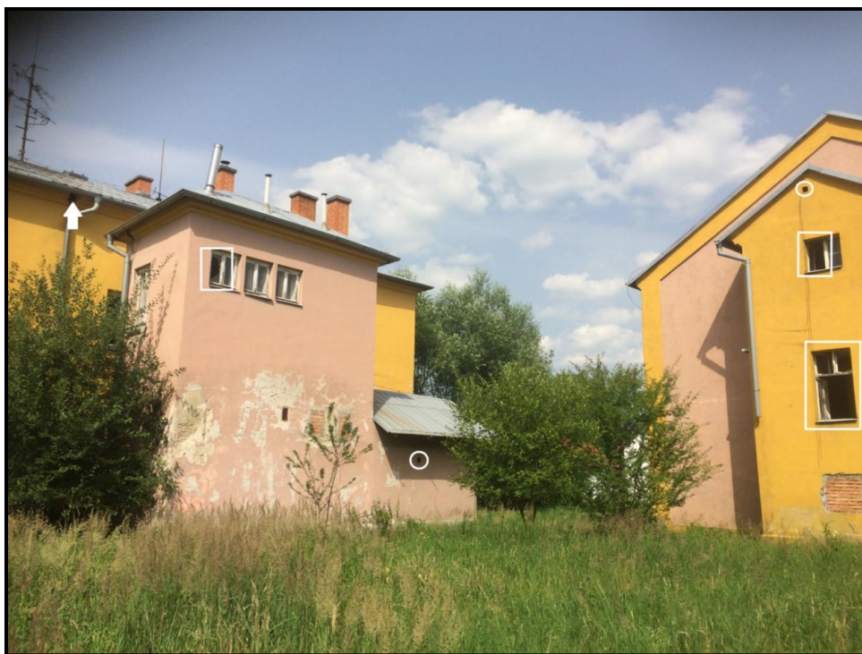
Obr. 2: Příklad potenciálních přístupových míst pro ptáky do interiéru domů – dutina na atikové římse (šipka), ventilační otvory bez mřížek (elipsy) a otevřená či rozbitá okna (obdélníky)
